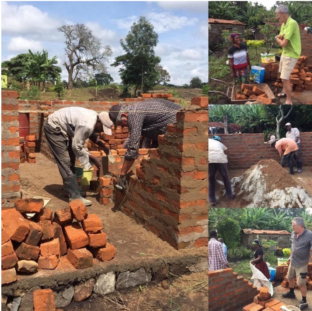
De steiger wordt ter plekke in elkaar geknutseld.
